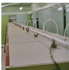
От основного пробозаборного воздуховода системы VESDA отходят капиллярные трубки, которые можно проводить внутрь шкафов с оборудованием, что обеспечивает возможность обнаружения дыма в шкафах на самых ранних стадиях его появления.
