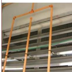
В кондиционируемых помещениях воздушные потоки уносят дым от потолка в вентиляционные отверстия системы рециркуляции воздуха. Пробозаборный воздуховод VESDA можно установить вдоль трубопровода системы рециркуляции, что обеспечит возможность раннего обнаружения дыма.
