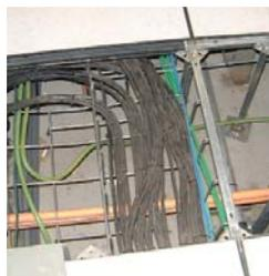
Пробозаборный воздуховод дыма системы VESDA следует устанавливать в закрытых зонах под съемными полами и вблизи электропроводки с высоким риском возгорания, что позволит обнаружить дым в этих зонах на ранних стадиях его появления.
